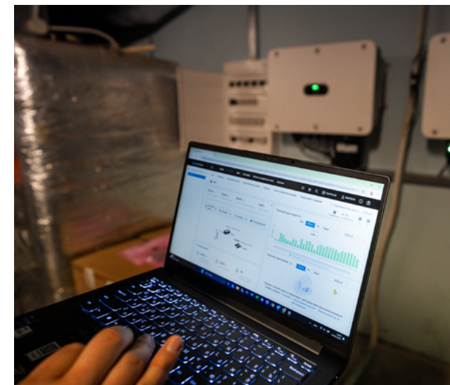
Зображення 29, 30 – Встановлені інвертори та онлайн-система моніторингу роботи сонячної електричної станції в будівлі Мінфіну
