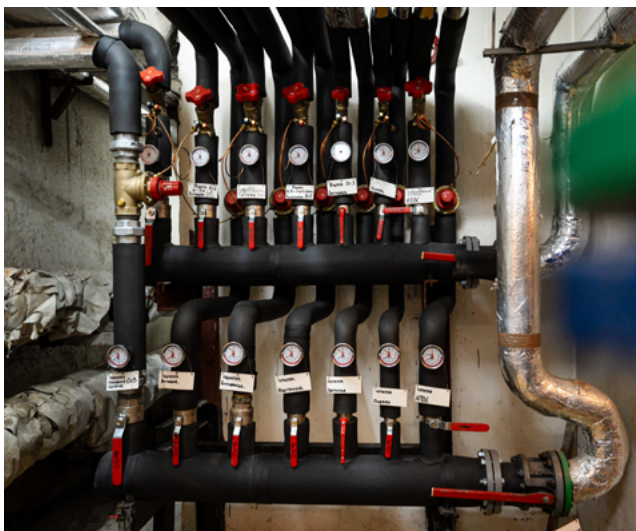
Зображення 4 – Встановленні автоматичні балансувальні клапани для системи опалення корпусу 2
