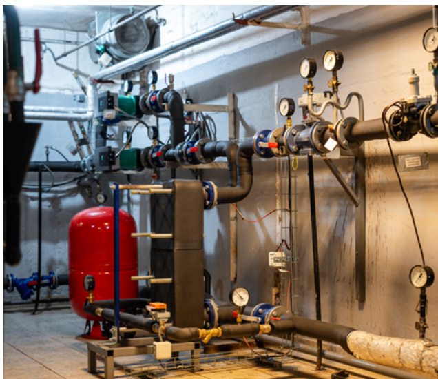
Зображення 8 – Вигляд модернізованого ІТП у корпусі 1
