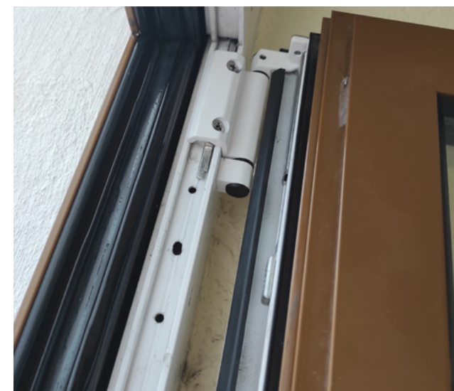
Зображення 26 – Вигляд стану вікон після виконання енергоефективного ремонту
