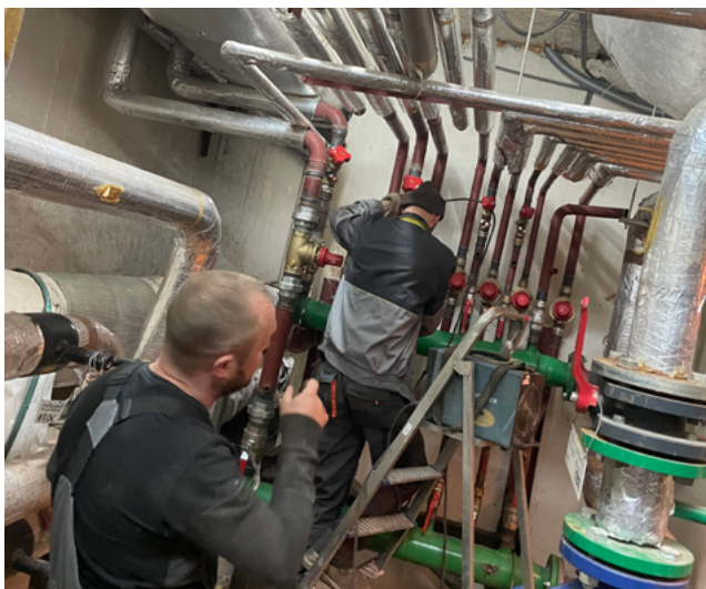
Зображення 3 – Встановлення автоматичних балансувальних клапанів для системи опалення корпусу 2
