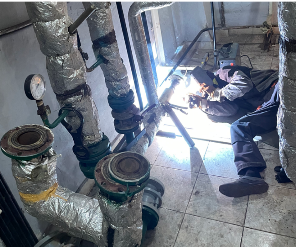
Зображення 4 – Виконання робіт із встановлення засобів обліку теплової енергії в межах реалізації проєкту Power Up
