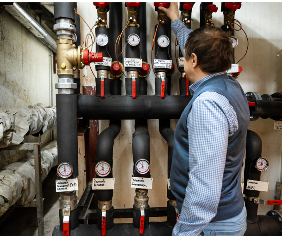
Зображення 11 – Процес налаштування автоматичних балансувальних клапанів, змонтованих в межах реалізації проєкту Power Up
