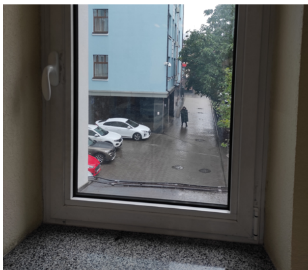
Зображення 25 – Вигляд стану вікон після виконання енергоефективного ремонту
